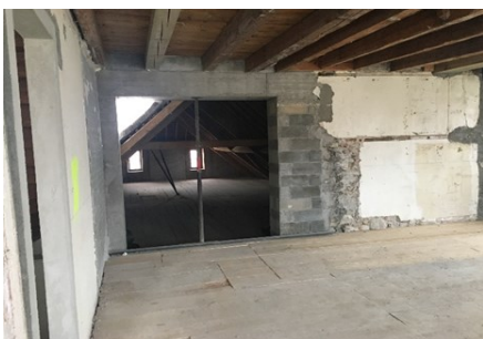
1 er étage. Appartement dans l'angle des 2 rues qui sera l'appartement n° 4 avec une partie en dessus du bâtiment administratif
